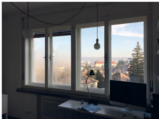
Obr. 22: Kastlová okna se po repasi v zimním období na vnitřní straně zasklení vnějšího okna začala rosit. (foto G. Kurtis)
