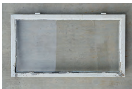
Obr. 7h: Rám venkovního křídla ventilačního okna z exteriéru se závěsy umístěnými na horní části rámu. (foto M. Klačka a J. Hanžl)
