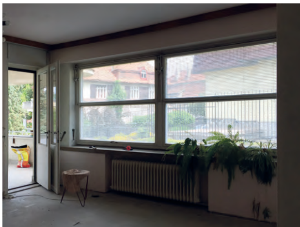
Obr. 20: Okno amerického typu z interiéru. (foto G. Kurtis)
