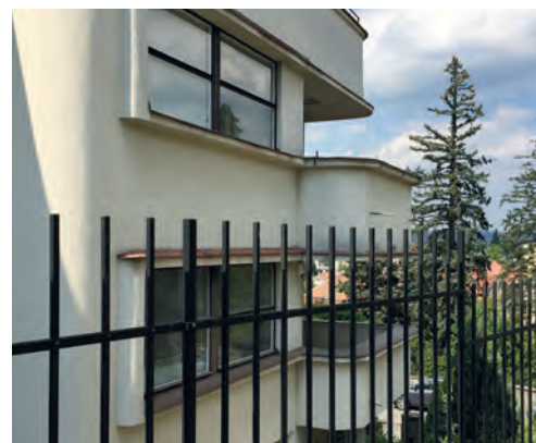
Obr. 19: Pohled na ocelo-dřevěná okna amerického typu ve vstupním rizalitu domu v 2. a 3. podlaží. (foto G. Kurtis)
