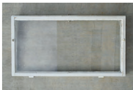
Obr. 7j: Rám vnitřního křídla ventilačního okna z exteriéru s dochovanými očky pro zachycení protikusu umožňujícího otvírání obou ventilačních křídel najednou – ventilačních nůžek. (foto M. Klačka a J. Hanžl)
