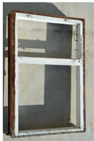
Obr. 7b: Okenní rám z exteriéru včetně zachovaných závěsů ventilačního okna a obrtlíků. (foto M. Klačka a J. Hanžl)
