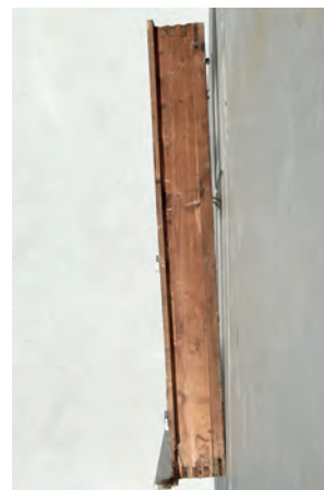
Obr. 7c: Okenní rám s pohledem na část rámu ve styku s oštěním – patrné spojení rámu ozuby. (foto M. Klačka a J. Hanžl)
