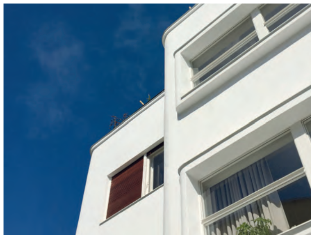
Obr. 21: Pohled na detail průčelí funkcionalistické vily po repasi okenních výplní a rekonstrukci fasády. (foto G. Kurtis)
