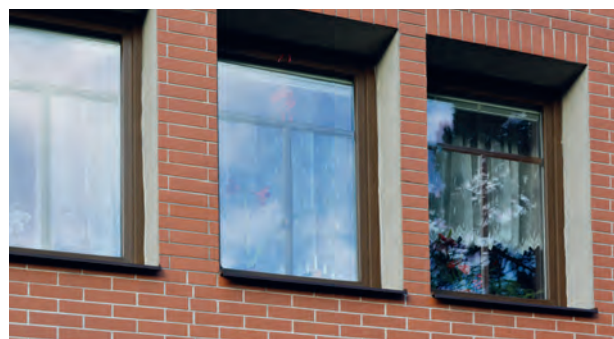
Obr. 11: Výměna oken za jednokřídlé plastové s členěním naznačeným meziskelním páskem. Z pohledu památkové péče zcela nevhodná poutčová úprava imitace dřeva a členění meziskelním páskem – ztráta jakékoliv souvislosti s historickým originálem a dobovou řemeslnou produkcí. (foto M. Šolc)
