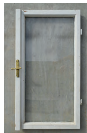
Obr. 7g: Rám vnitřního křídla z interiéru s dochovanou okenní olivou a klapačkou kryjící rozvoru. (foto M. Klačka a J. Hanžl)
