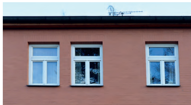
Obr. 13: Dřevěná jednoduchá okna z tzv. „europrofilů“ se zachovaným trojkřídlým konstrukčním řešením lze v současnosti v daném území považovat za vhodný kompromis mezi tradičním autentickým vzhledem a současnými požadavky na moderní okna uživateli. (foto M. Šolc)
