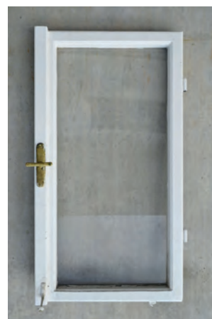
Obr. 7f: Rám venkovního křídla z interiéru s dochovanou okenní olivou a nárazníkem. (foto M. Klačka a J. Hanžl)
