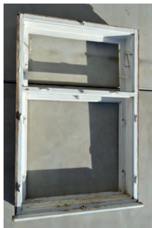
Obr. 7a: Původní trojkřídlé ventilační okno z doby „batovské“ výstavby deponovaného v Metodickém centru moderní architektury v Brně – okenní rám z interiéru včetně zachovaného kování a ventilačních nůžek. (foto M. Klačka a J. Hanžl)
