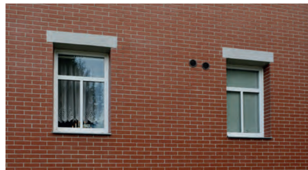
Obr. 9: V současnosti nejtypičtější ukázka náhrady výplní otvorů dlouhodobě akceptované výkonným orgánem státní památkové péče ve Zlíně. Jednokřídlá jednoduchá plastová okna s naznačeným dělením předstupujícím před rovinu zasklení. Po materiálové a konstrukční stránce, dle názoru odborné organizace, nesplňují požadavky ani na výplně v provedení dobové tvarové analogie. (foto M. Šolc)
